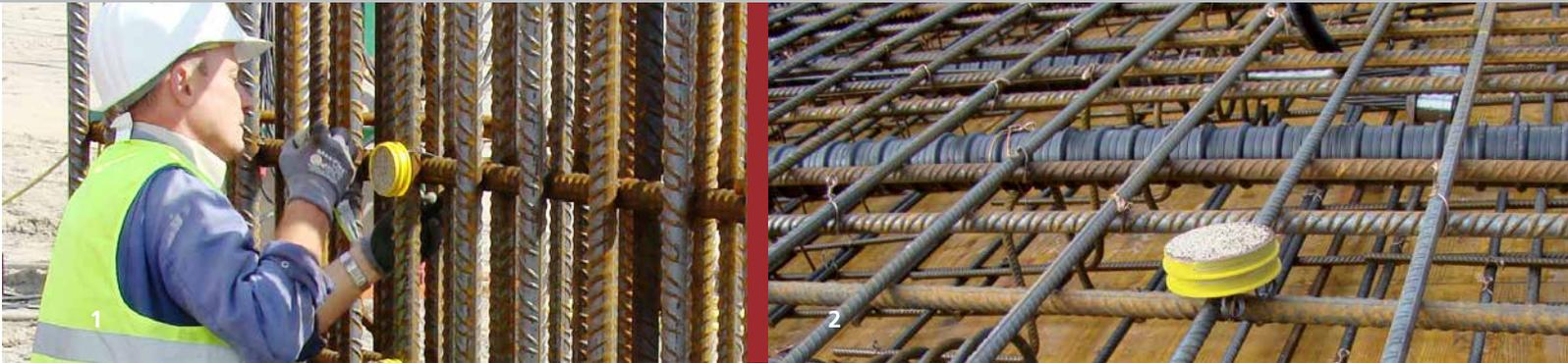
1 *Beton-Transponder in Rotterdamer Kaimauer.*
